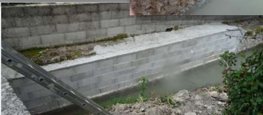
Étanchéité du bassin réalisée
