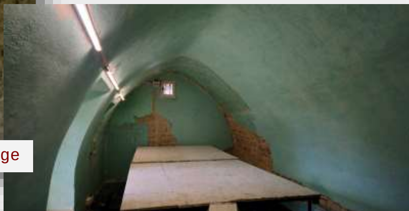
Préparation des murs
